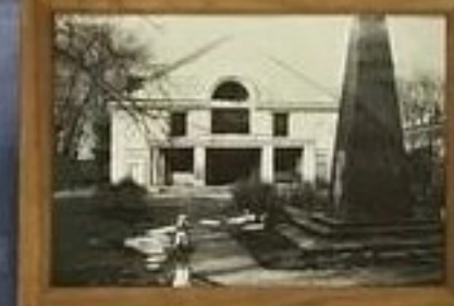
Здание бывшего завода
